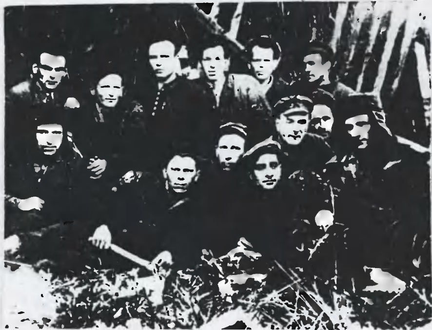
Międzynarodowa brygada ziemiokopów i cieśli z łożona z jednego Polaka, Rosjan, Ukraińców, Estończyków, Węgra i Łotyszów.
