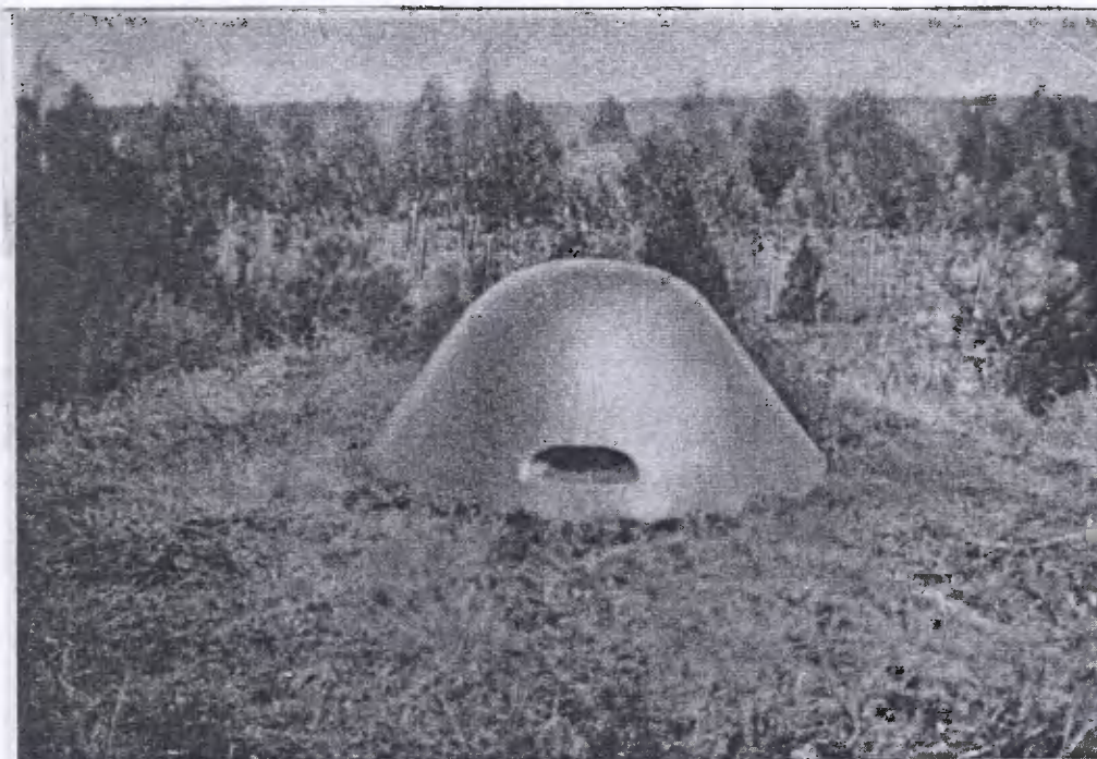
Kopuła pancerna schronu bojowego w rejonie Zdbic
